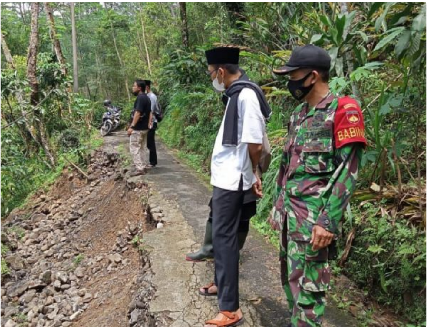
Longsor menimpa ruas jalan Desa Panusupan, Kecamatan Rembang, Kabupaten Purbalingga (FOTO: Koramil 13/Rembang Kodim 0702/Purbalingga)
